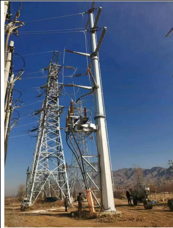
本季度施工现状 3
