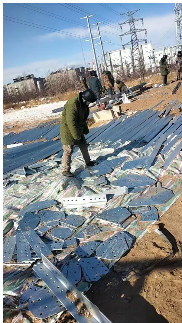
本季度施工现状 1
