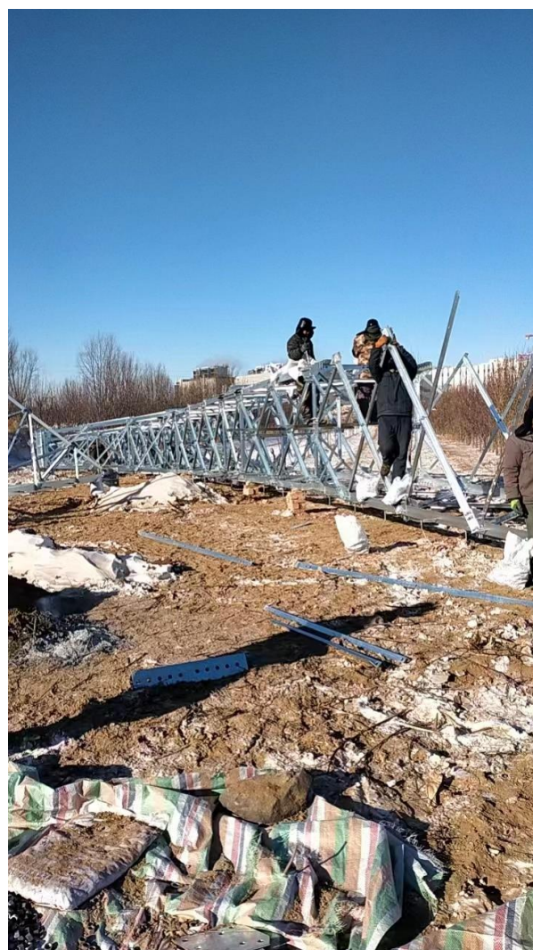
本季度施工现状 2
