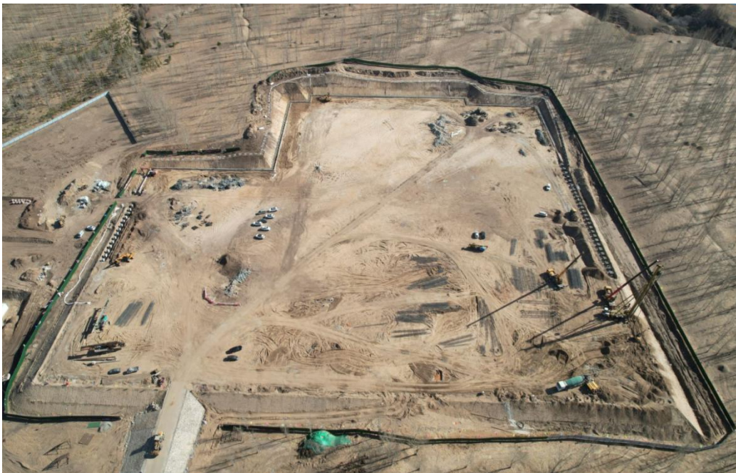
进站道路土方施工
