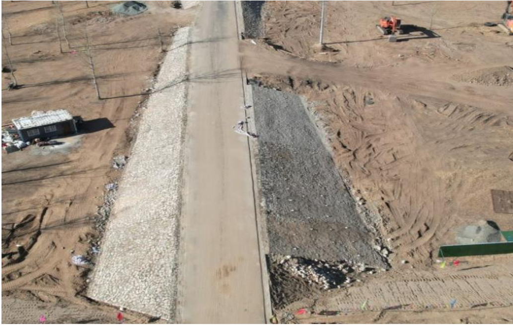
进站道路护坡
